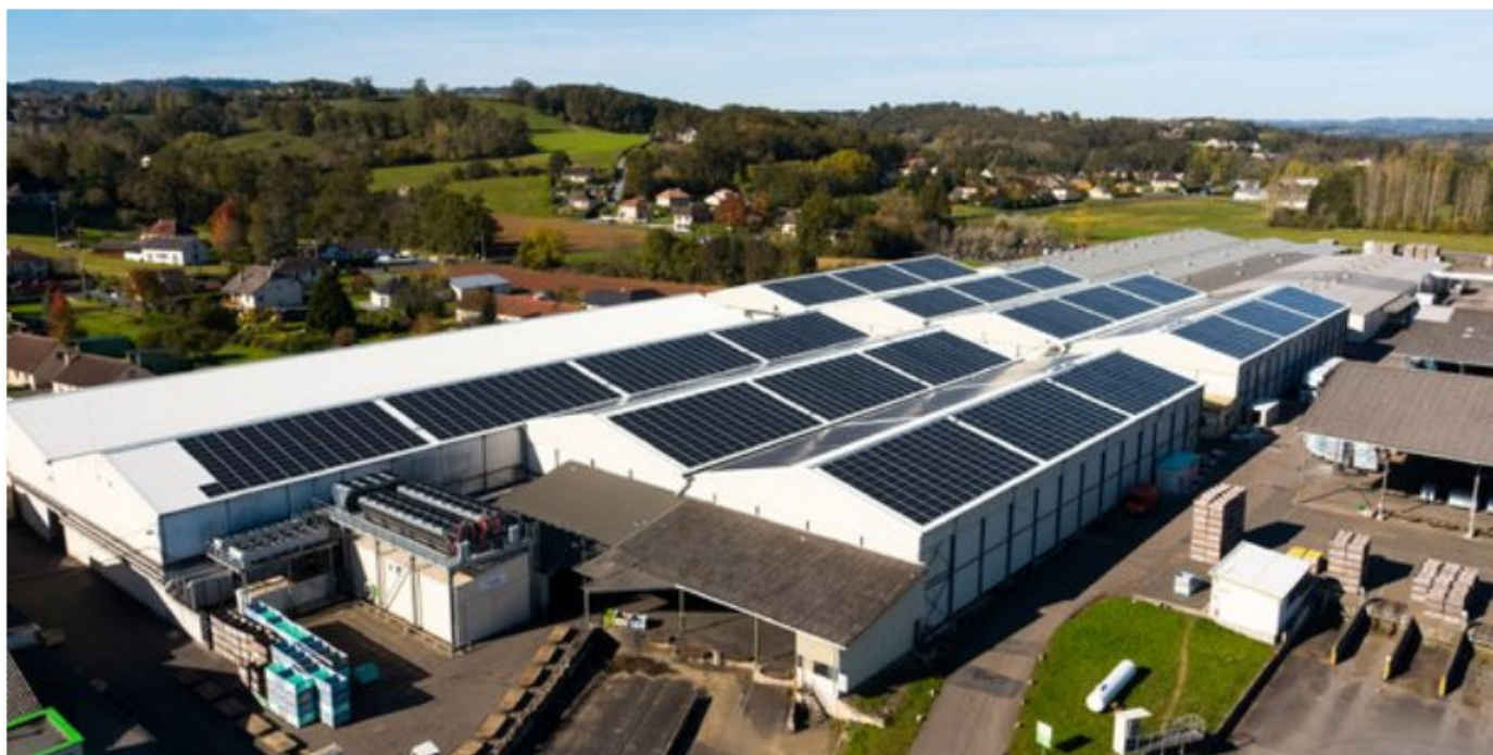
La centrale photovoltaïque de Cooplim s'étend sur 10.000 m 2 . (Crédits : Apex Energies)
