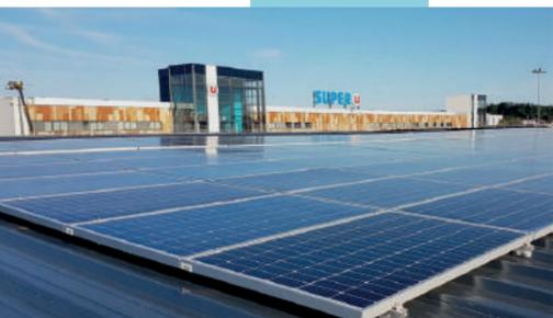
**LE SUPER U SAINT VIT** est équipé d'une centrale photovoltaïque en autoconsommation de 312 kWc installée sur le parking couvert de 1700 m<sup>2</sup> de la grande surface en Région Bourgogne Franche Comté. Sur ce projet solaire en toiture, 12% de la consommation électrique annuelle sera effacée grâce à l'énergie solaire. L'installation permettra d'éviter 850 Tonnes de CO<sub>2</sub> sur 30 ans. La centrale en autoconsommation produira annuellement 310 MWh.
